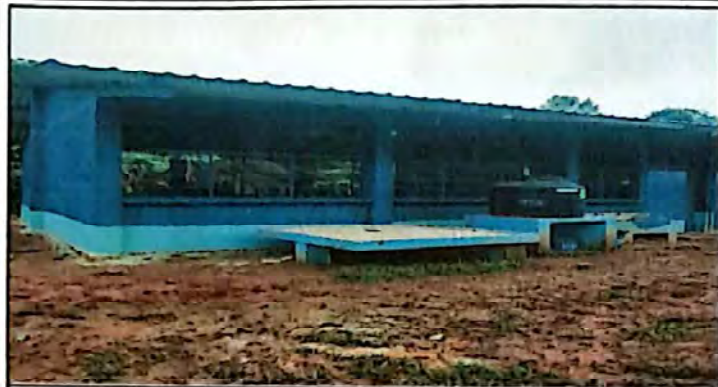
Foto1: Finalización de levantado de pared de block
