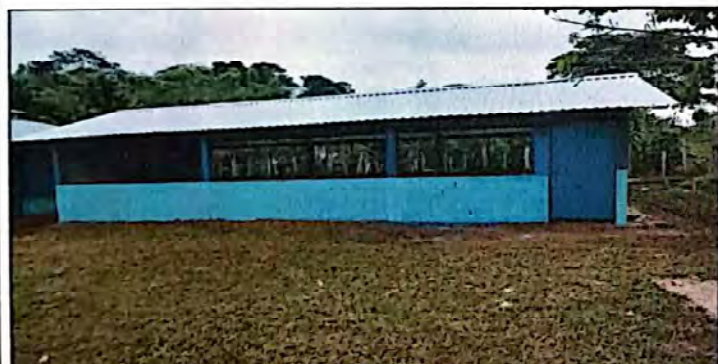
Foto 5: Finalización de rehabilitación de pared de block y cambio de piso de esta aula
