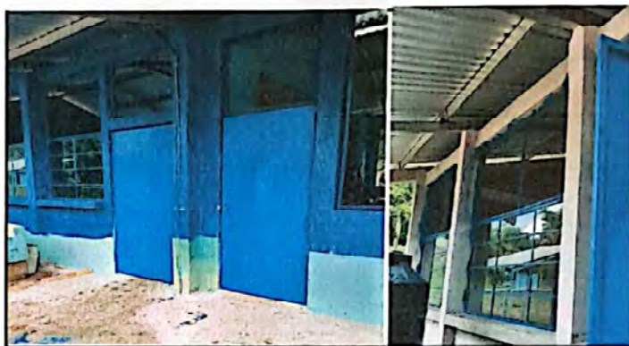
Foto 4: Finalización de sustitución de 2 puertas de madera por dos de metal y cambio de ventana de madera por ventada de metal con vidrio.
