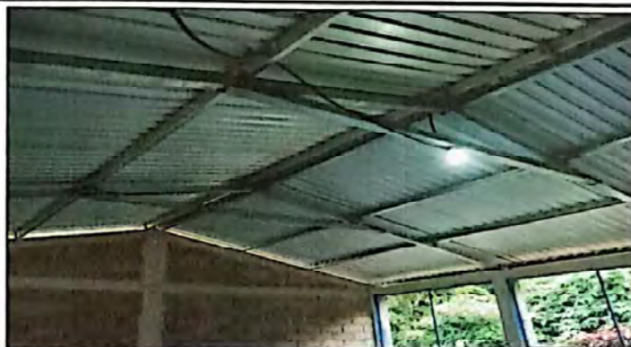
Foto 2: Finalización de cambio de estructura de techo y cubierta de lamina
