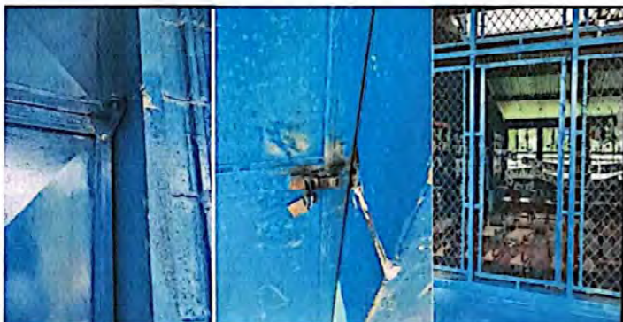
Foto 6: Reparación de dos puerta y cambio de malla de una ventana.
