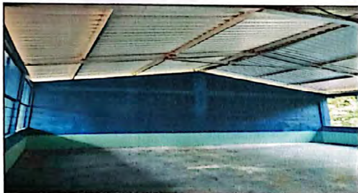
Foto 3: Finalización de cambio de piso
